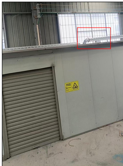
危废库废气（管道收集）
