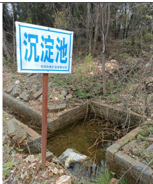
露天采场雨水沉淀池
