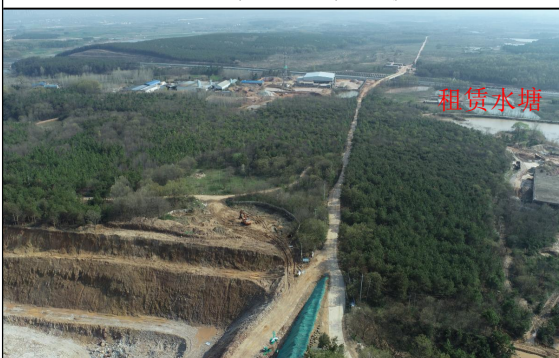
露天采场矿区南侧
