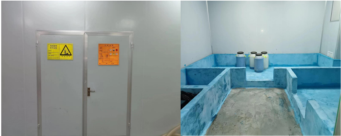
危险废物暂存库
